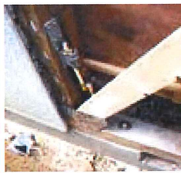
耐震改修(筋かい補強)
