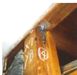
耐震改修(接合部の補強)
