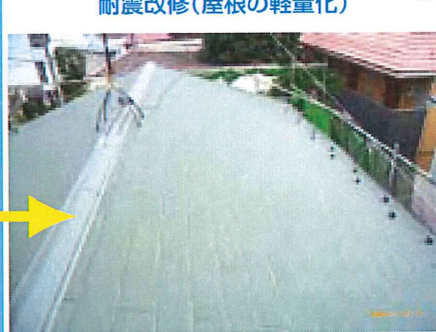
耐震改修(屋根の軽量化)
